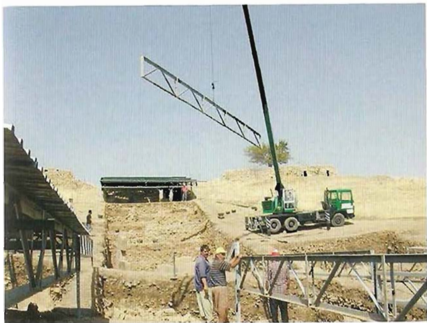
Resim 56: Koruma çatısı, eğitimli işçiler ve vinç yardımıyla yapıldı.
